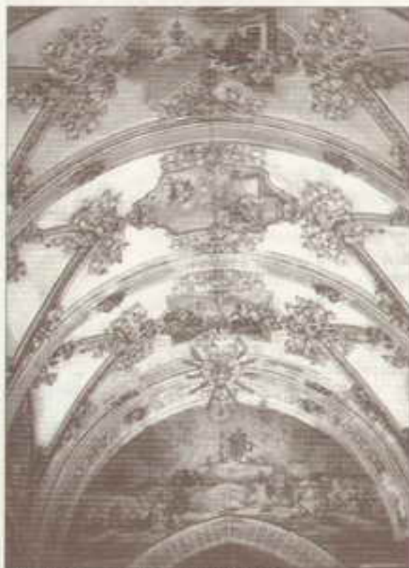
Bóveda barroca de la Iglesia de Montesión
