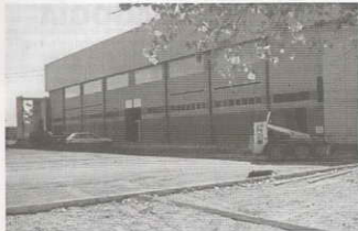
Exterior del nuevo pabellón
